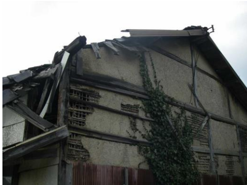
● 所有する老朽危険廃屋の解体・撤去を検討している…。
