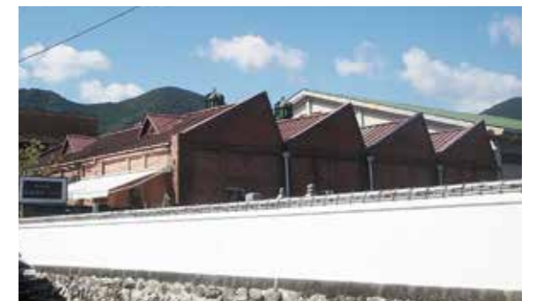
ノコギリの歯のような屋根をもつ織物工場 桐生市内には約220棟のノコギリ屋根工場が現存する。
