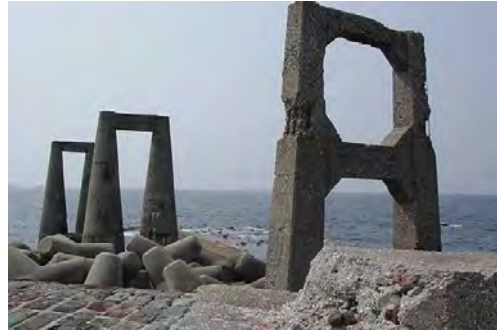
ローダー橋脚 (史跡 佐渡金銀山遺跡)
