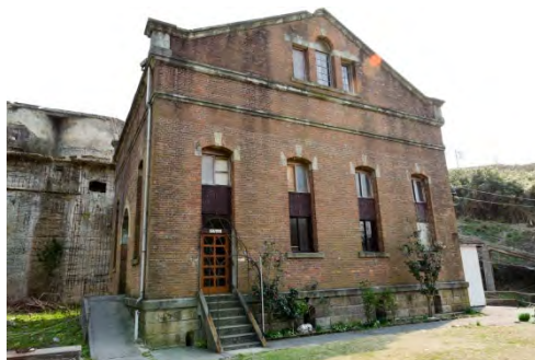
北沢火力発電所発電機室棟 (史跡 佐渡金銀山遺跡)
