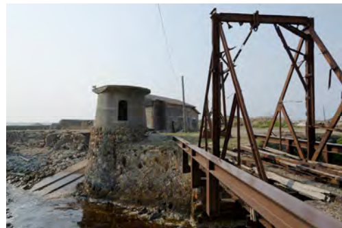
トラス橋とクレーン台座 （史跡 佐渡金銀山遺跡）
