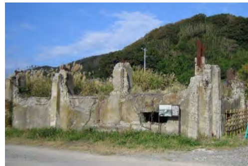
大間火力発電所 (史跡 佐渡金銀山遺跡)
