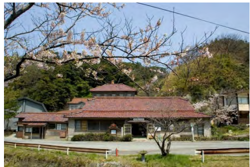
老朽化による劣化が進んでいる 旧御料局佐渡支庁
