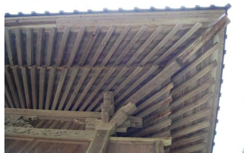
二夕軒本繁垂木の造り
