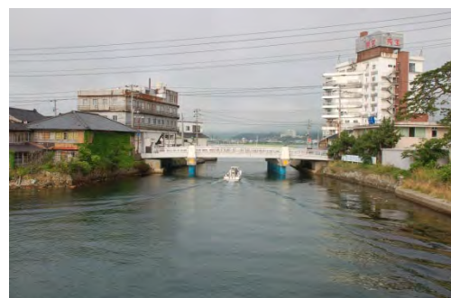
現在の両津橋付近
