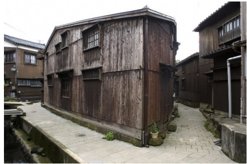
佐渡市宿根木伝統的建造物群保存地区
