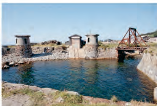
図7 大間港（クレーン台座とトラス橋）
