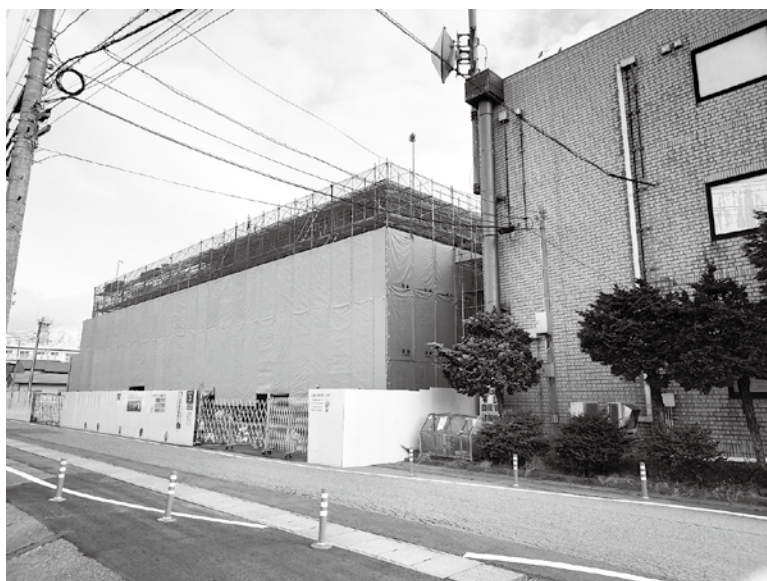
建設中の市役所新庁舎
