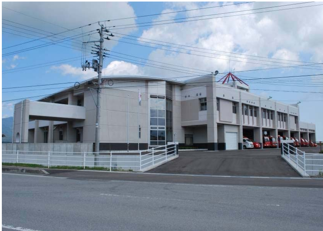
佐渡市消防本部・中央消防署・佐渡市防災センター
