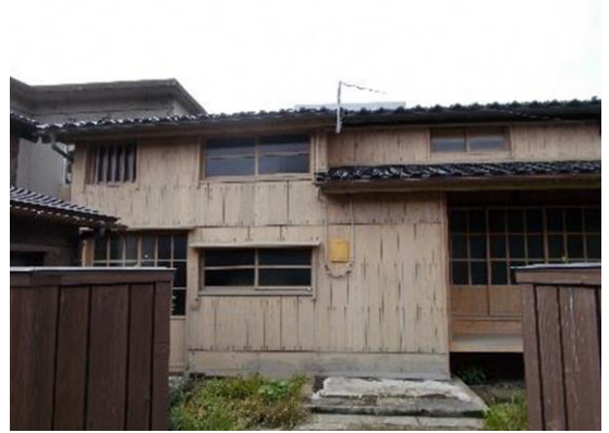
【住居（受け入れ予定）の外観】
