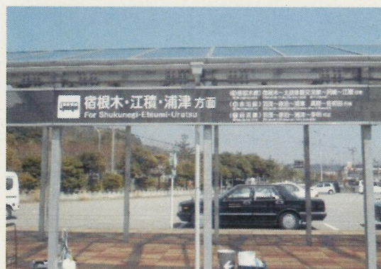
施工後（宿根木方面）
