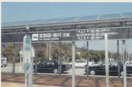
施工後（佐和田方面）
