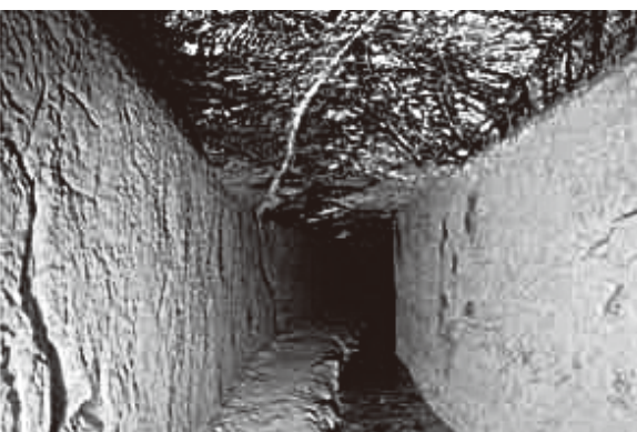
▲南沢疎水道内部 上部を山形に切り、断面は将棋の駒形になっている。
