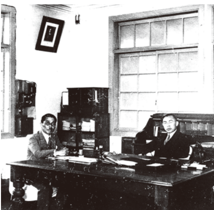
▲明治期の鉱山長室の内部
