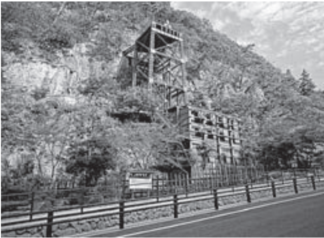
おおだてたてこう 大立竪坑 1877年日本最初の欧米の技術による竪坑（斜坑・横坑などに対し、垂直に掘り下げた坑道）が開削され、1989年の休山まで使用された。
