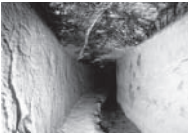
▲南沢疎水道内部
