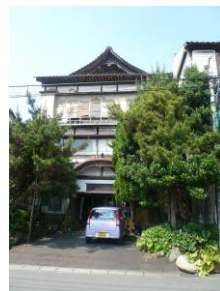
佐州館など老朽化した建物の保全・活用
