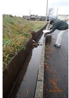
〈水路の確認〉 (行谷小学校、長畝地内)
