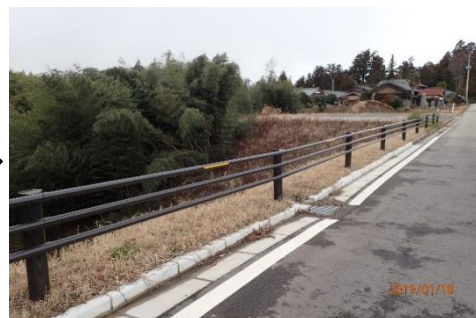
〈ガードパイプの取付後〉
