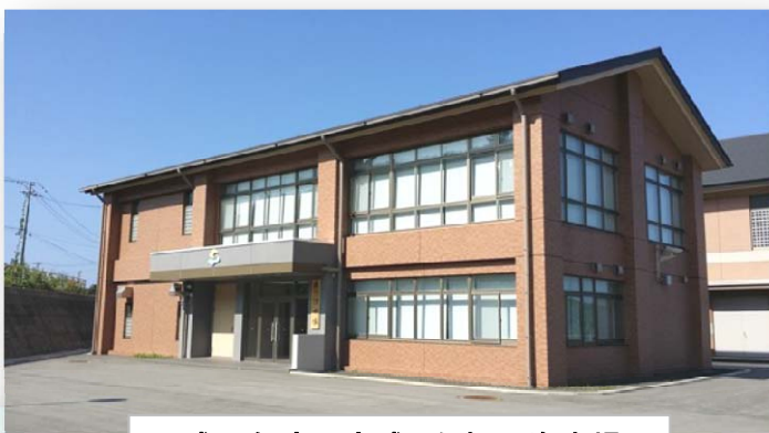
平成24年度に完成した相川浄水場
