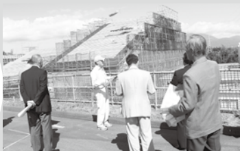
改築中の永安館
