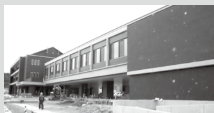
建設中の相川支所
