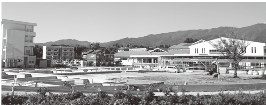
建設中の金井統合保育園
