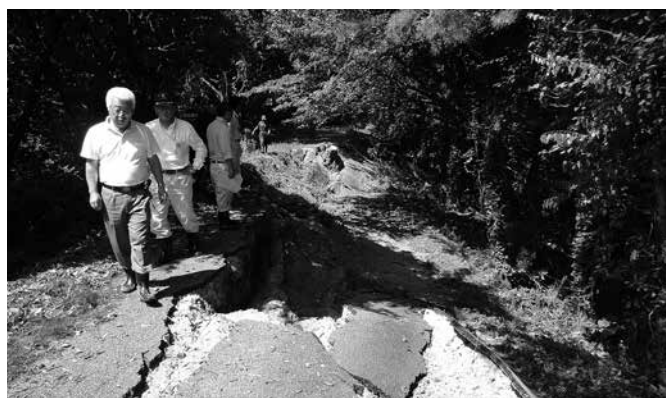
所管の産業建設常任委員会による現地視察
