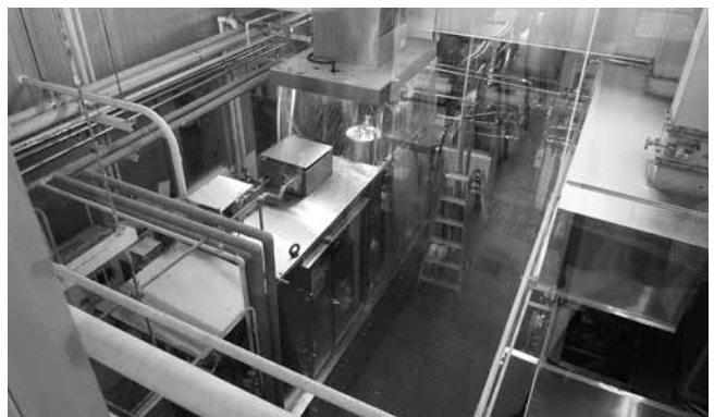
現在使用している生乳プラント
