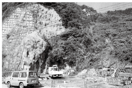
野浦地内の落石対策工事
