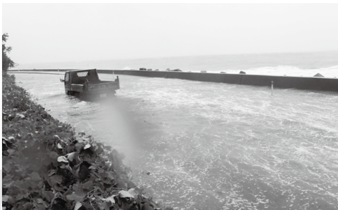
10月の台風21号で越波により冠水する県道
