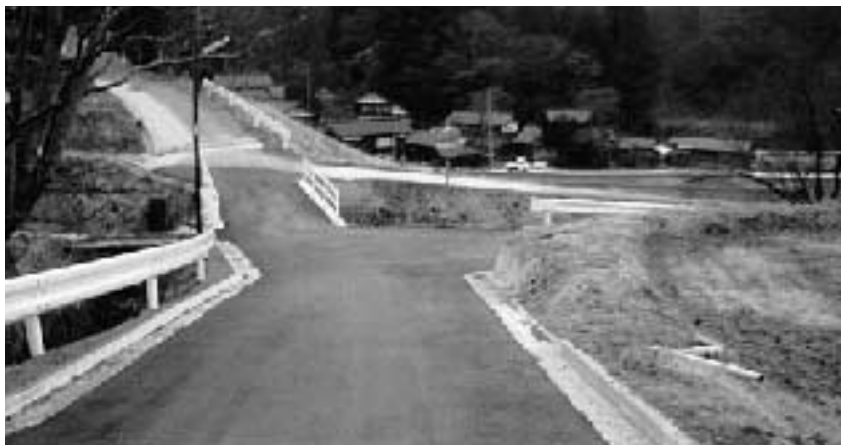
市道岩田線（羽茂地区）
