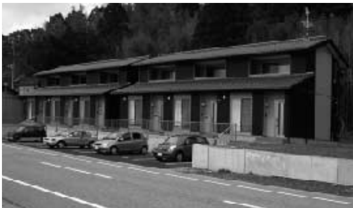
完成した小熊住宅（赤泊地区）
