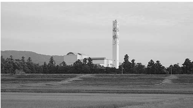
平成11年に稼動した両津クリーンセンター
