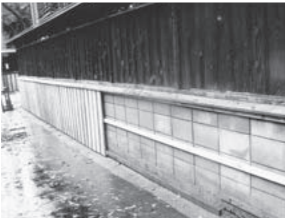
村上市 改修中の黒板塀
