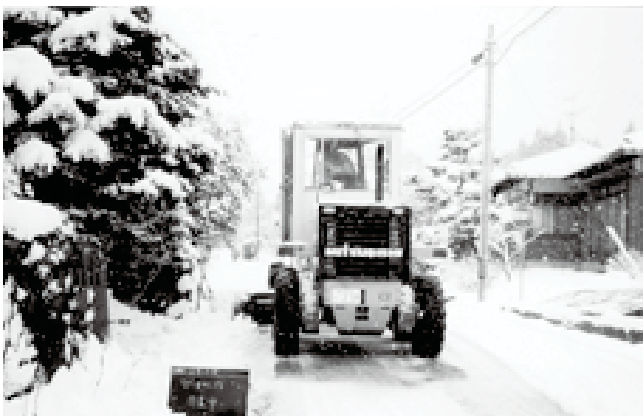
グレーダーによる除雪作業
