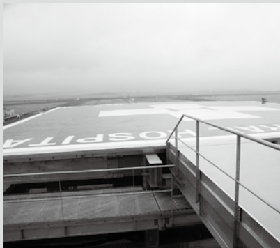
屋上ヘリポート
