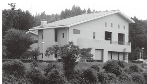
両津浄化センター
