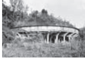
北沢地区シクナー 水を含んで泥状になった鉱石から鉱物と水を分離する施設
