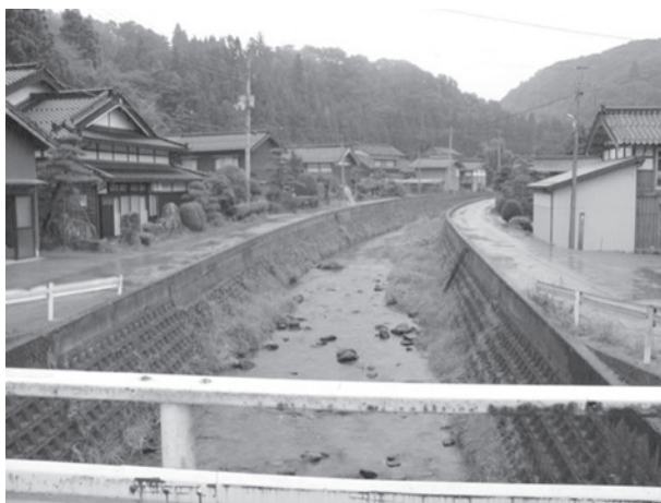
写真1 久知河内集落を下流から望む
