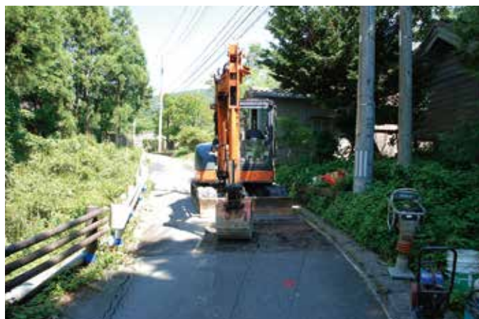
発掘調査の様子(発掘には重機を用いることもあります)
