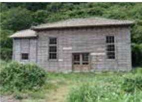
大正8年から昭和52年まで稼働した水力発電所。ここから9kmにわたって送電線が設置され、鉱山へ電力が供給された。
