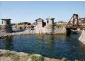
明治25年に「たたき工法」によって築かれた鉱山専用の港。鉱石の運搬や鉱山の資材搬入に使われた。
