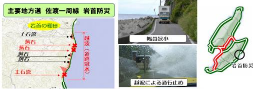
越波による道路冠水
