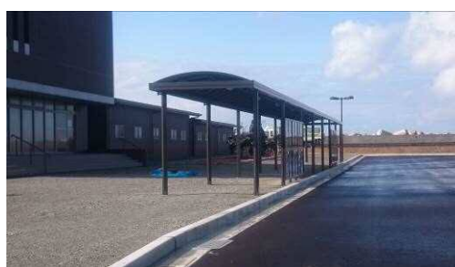
相川支所の出入り口前面に設置された乗降空間
