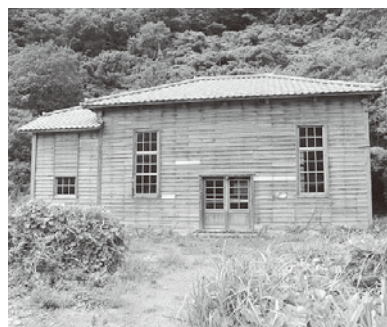
現存する戸地川第二発電所の建物
