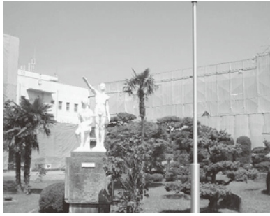
耐震工事中の校舎
