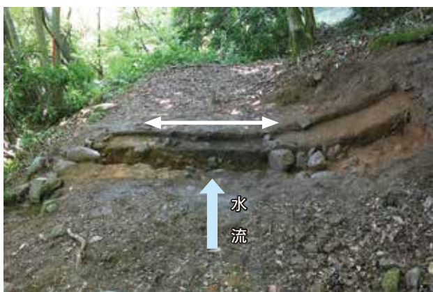
五社屋堤への導水路
