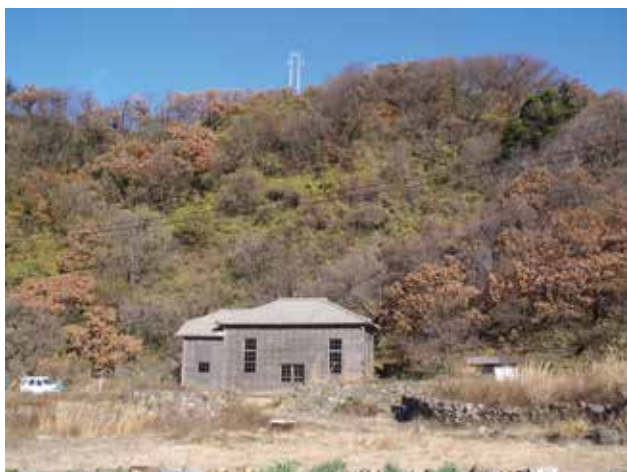
戸地川第二発電所（南から）
