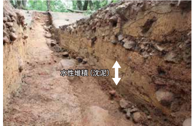
堤内の堆積状況
