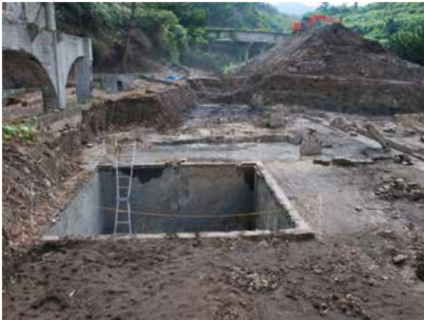
鑄造工場ピット跡（西から）
