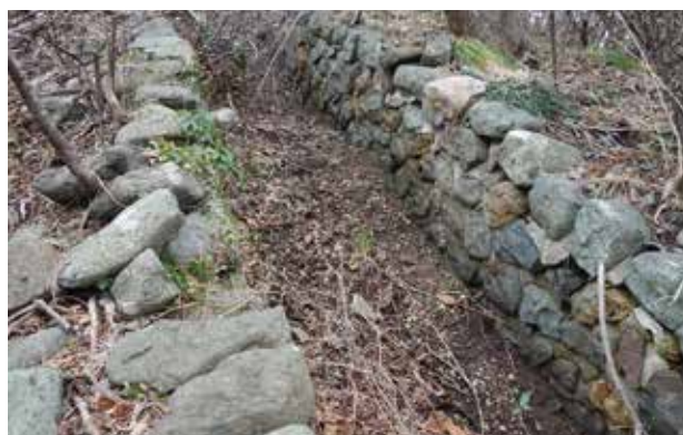
余水路の石積み水路（西から）
