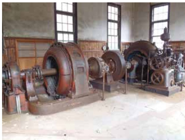
戸地川第二発電所内の機械類
