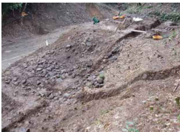
せりば遺跡のガラ石堆積状況
