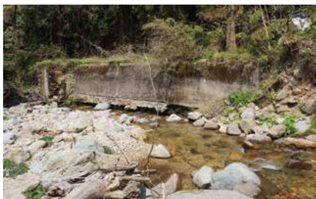
戸地川第二発電所の取水口（南から）
