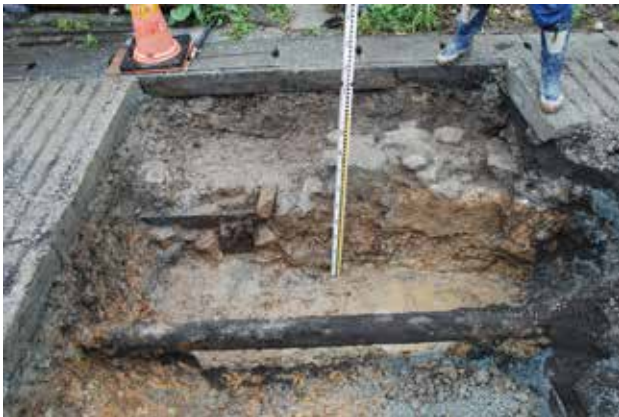
石垣・木柱・板検出状況（南から）
