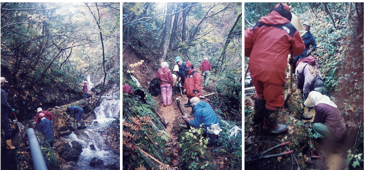
図4-16 下江(シタエ)の修理事業
