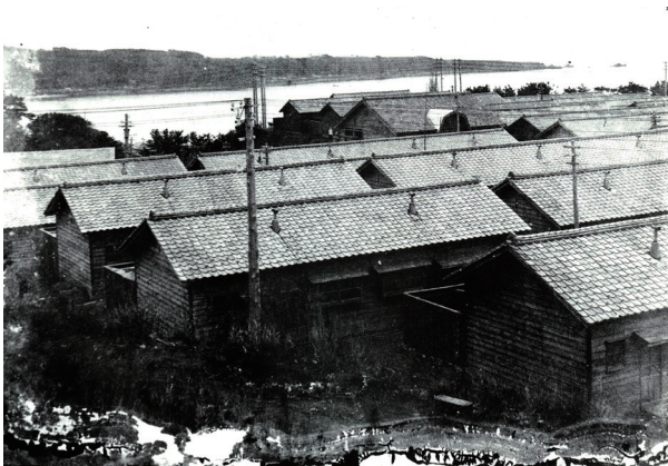
図6-25 昭和15年(1940)頃の鉱山住宅(下山之神町)
