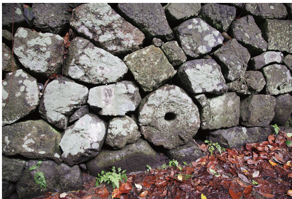
図6—19 石臼が転用された石垣(下寺町)
