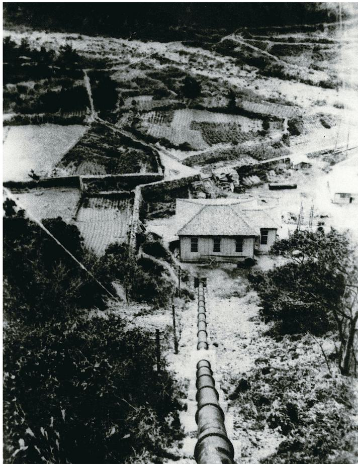
古写真2 戸地川第二発電所と水圧管路
