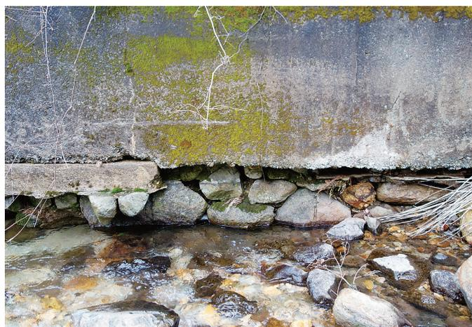
取水口コンクリート閉塞部分と石積基底部（南西から）
