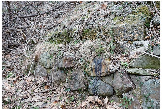
水圧管路石積及び鉄筋コンクリート基礎
