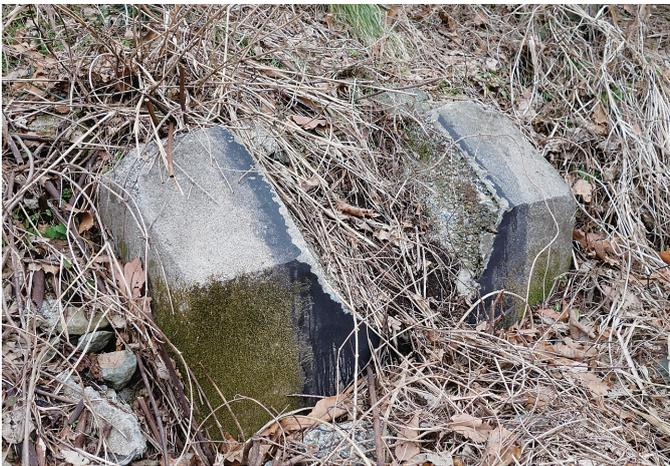
水圧管路鉄筋コンクリート基礎
