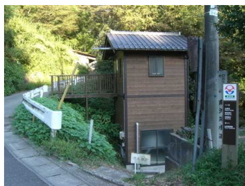
6 坑口に隣接する坑水処理施設
