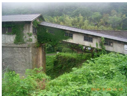
12 ベルトコンベアーヤードと貯鉱舎
