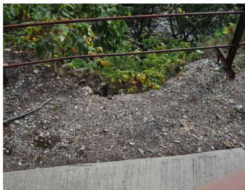
8 通路端部（落下防止柵）
