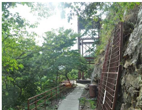
6 通路及び石垣
