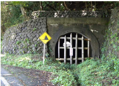
23 神明トンネル
