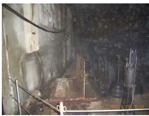
4 大立捲揚室内部
