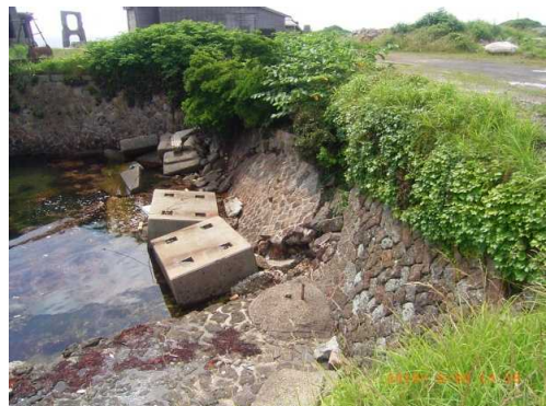
12 大間港護岸現状
