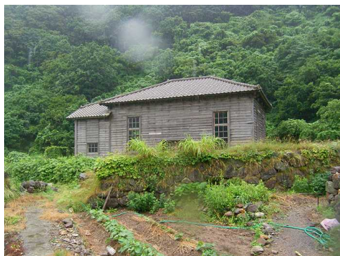
1 戸地川第二発電所
