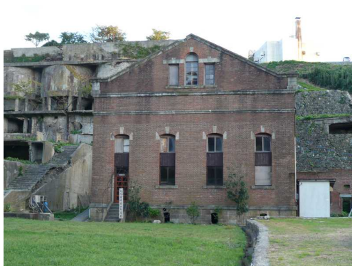
7 火力発電所発電機室棟
