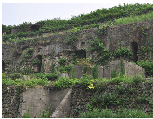
4 旧青化・浮選鉱所跡 植物による浸食状況
