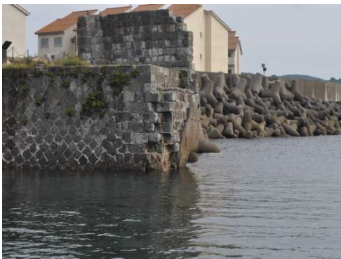
13 大間港護岸現状+消波ブロック
