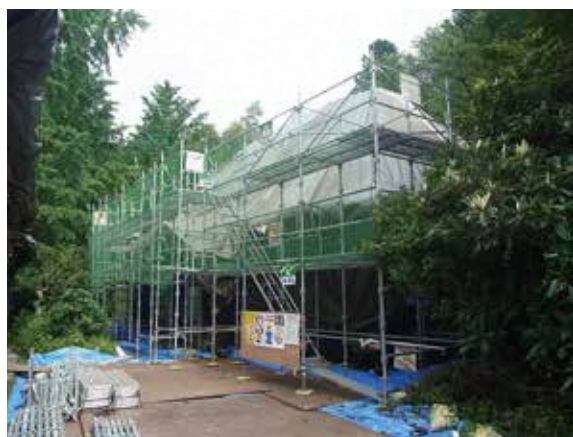
金子勘三郎家住宅の保存・活用に向けた修理工事の様子
