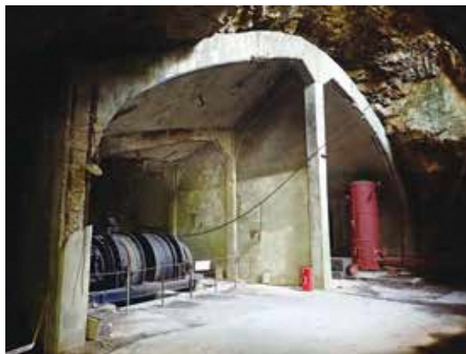
調査を予定している大立堅坑捲揚機室
