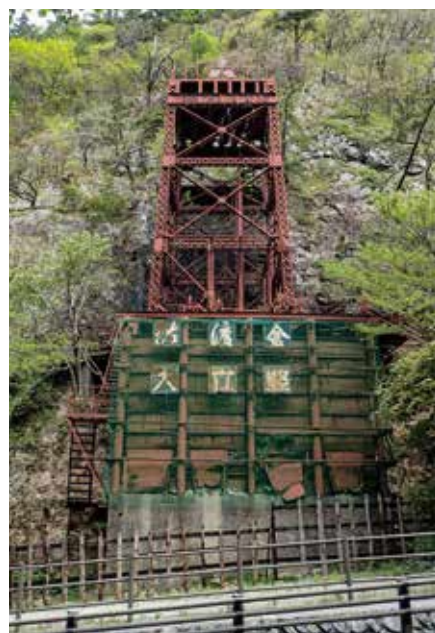
修理工事を予定している大立堅坑櫓
