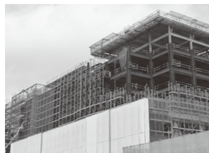
佐渡総合病院移転新築工事
