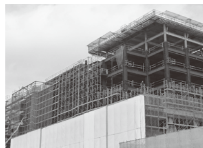
佐渡総合病院移転新築工事
