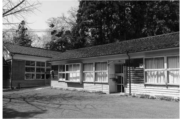
改修工事を終えた旧西三川小学校笹川分校
