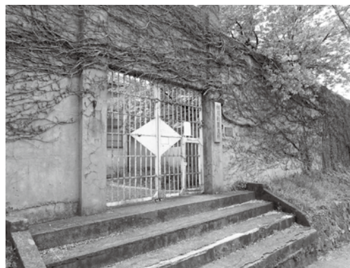
旧相川拘置支所事務所門と塀
